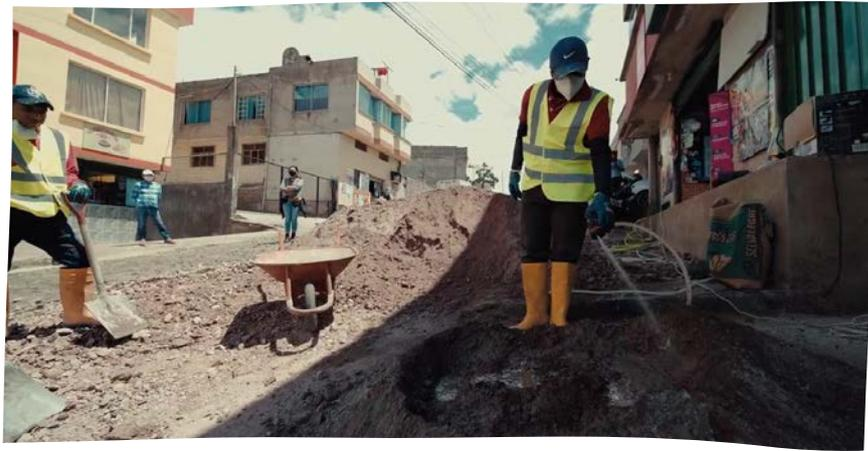
**Figura 8.** Hidratación del material de relleno
