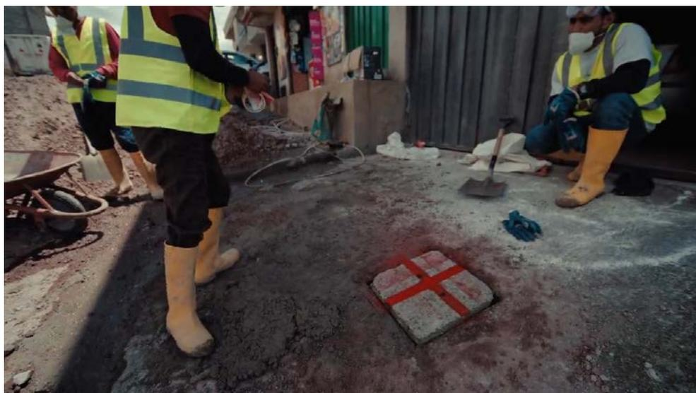
**Figura 11.** Señalización de la ubicación de pozo
