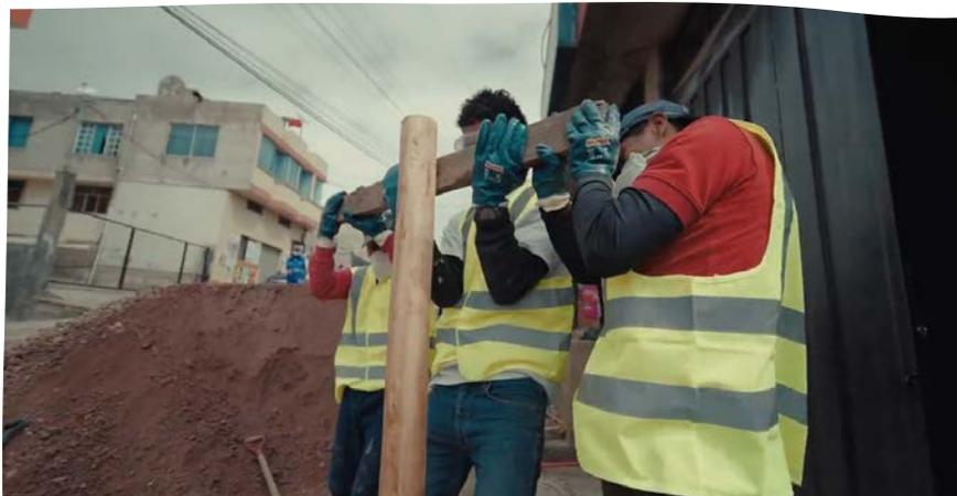
**Figura 9.** Compactación del material en el pozo séptico
